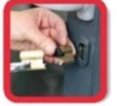
...alors le corps du cylindre peut se rompre au centre
