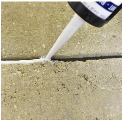
Étanchéité d'un joint de dilatation
